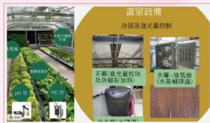
水耕溫室設備
